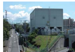
光明池変電所
