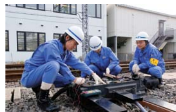
ポイントの点検
