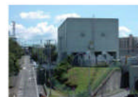
光明池変電所
