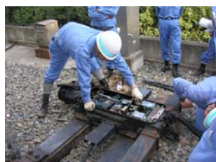
電気転てつ器の整備
