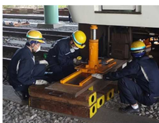
脱線車両の復旧
