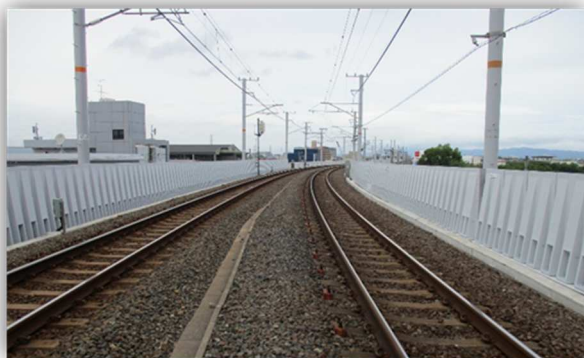
ブロック高欄改修
