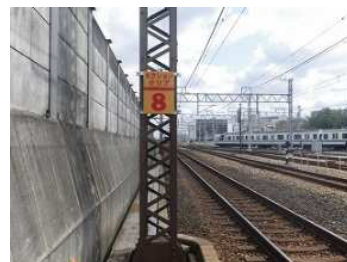
セクションクリア表示板（列車の両数ごとにエアセクションを通過した地点を示す）
